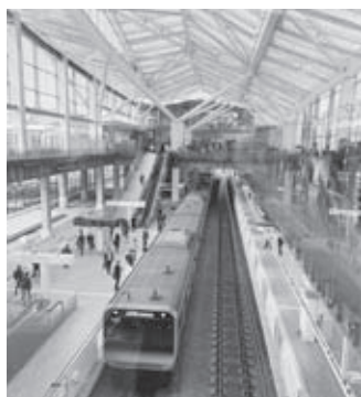
高輪ゲートウェイ駅 天井の集成材に県産材を使用して 県内の事業者が製造
