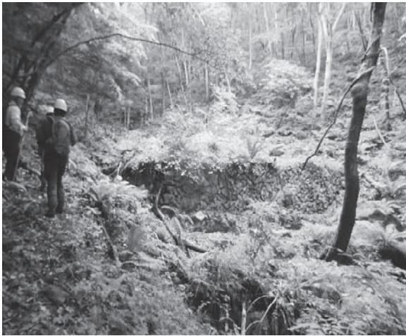
斜面下部からの施設全景
