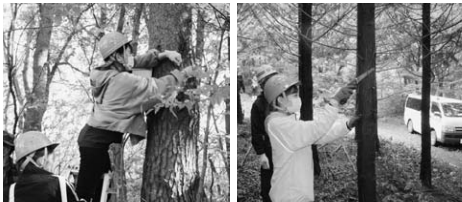
巣箱の再設置と除伐作業
