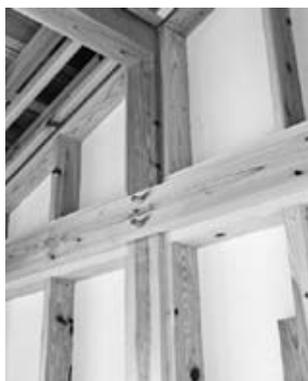
柱と土台、柱と梁、桁の接合は「長ほぞ込み栓」でしっかりと木を組みます。
