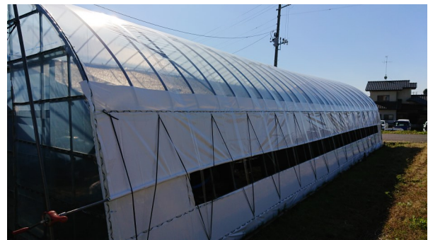
写真9:簡易ハウス外観(例 約30坪遮光ハウス)
