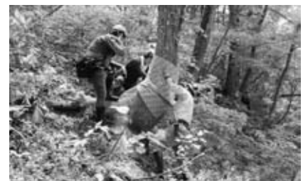
南会津町における粘着シート設置状況
