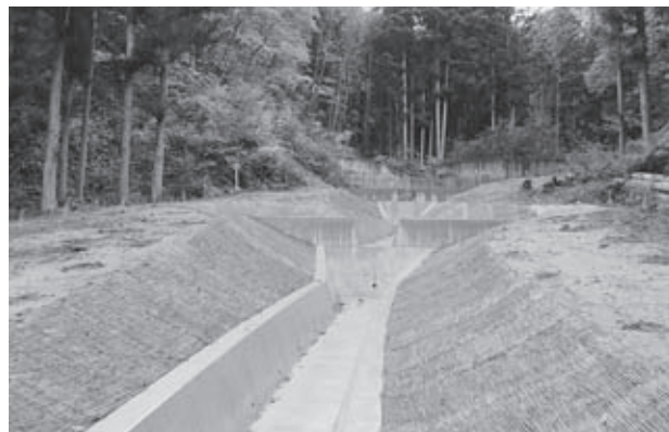
写真2 渓流の浸食を防止するための流路工
