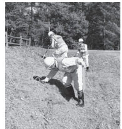
盛土の点検状況
