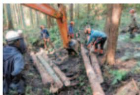
丸太利用洗越しの施工（横丸太の据付）
