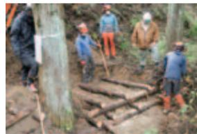
丸太組工の作設実習（2箇所目、2段目埋戻し）
