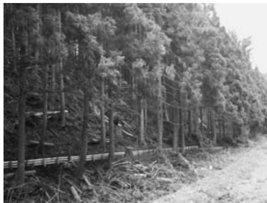
土砂の移動を抑える丸太筋工
