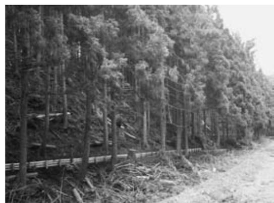
土砂の移動を抑える丸太筋工
