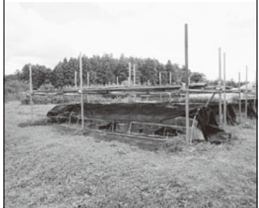
クロモジ挿し木簡易トンネル施設
