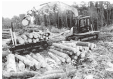
伐採木の搬出状況
