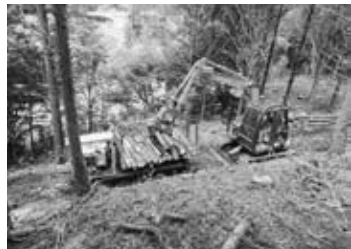
路網作設・材の搬出 (田村市常葉町)
