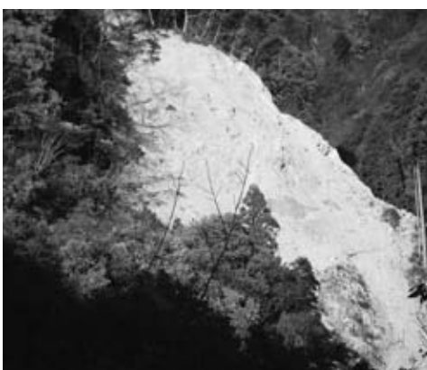
法面の崩落（被災時）（いわき市桐ヶ岡線）
