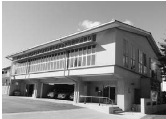
R 2. 3 竣工 須賀川土木事務所（RC+木造の混構造）
