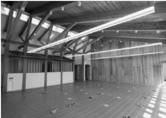
R 2. 3 竣工 須賀川土木事務所内装
