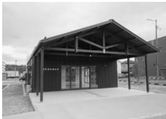
R 2. 10 竣工 復興公営住宅整備_南相馬市南町集会所
