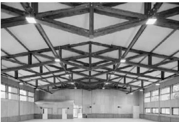
実習棟内部の様子
