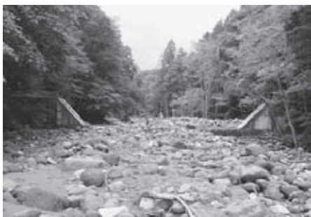
施工前（H元年既設治山ダムを下流より望む）
