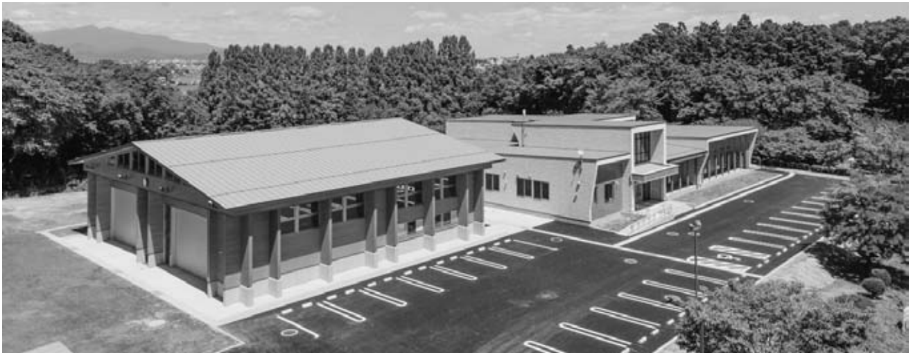
新施設全景（右奥：研修棟、左手前：実習棟）
