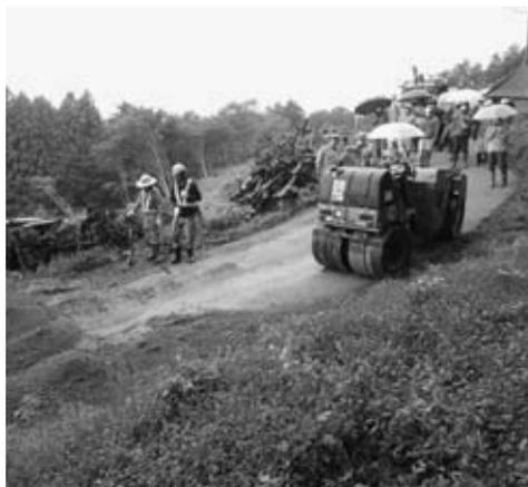
鋼スラグは作業道の路面補強材として林業を営んでいる方々への活用が期待されることです。福島水源林整備事務所では、令和三年度から実施している更新伐や間伐等で生産された材の搬出に欠かせない路盤強化等の路網整備を計画的に実施していくこととしています。
