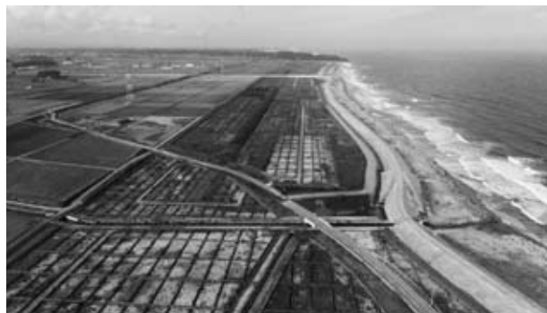
原町地区の整備状況 (R4年9月県上空より撮影)
