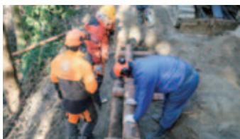
丸太組工の作設実習(2段目ヨコ木固定)
