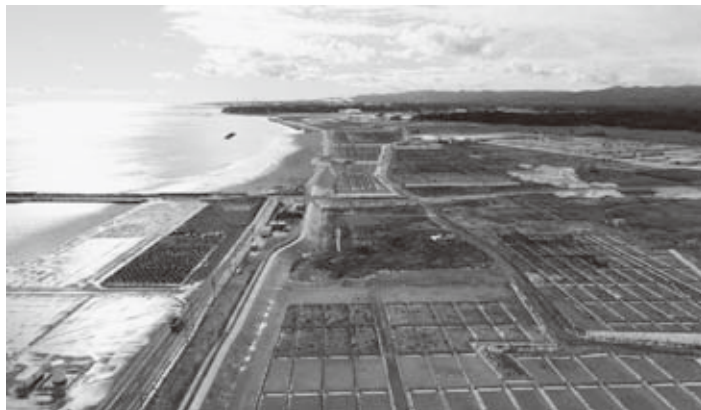
令和5年度海岸防災林造成事業(浪江地区)
