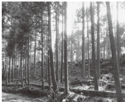
土砂の移動を抑える丸太筋工
