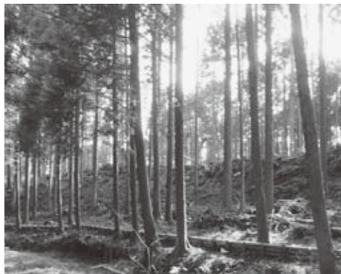
土砂の移動を抑える丸太筋工
