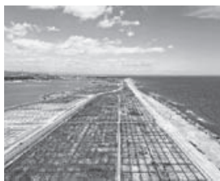
復旧工事完了後
