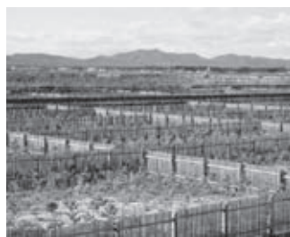
植栽工、丸太防風柵工・静砂垣工
