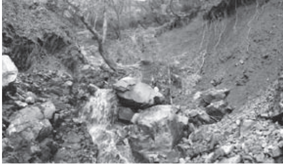
令和4年8月3日～4日の豪雨による西会津町の林地被害状況
