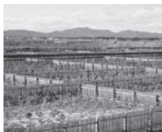
植栽工、丸太防風柵工・静砂垣工
