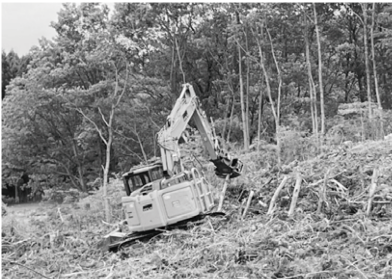
一貫作業（伐採機械による地掃え）
