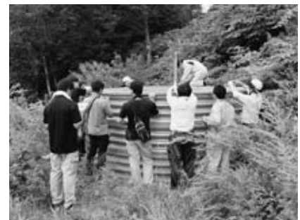
地すべり防止工事の効果確認の様子
