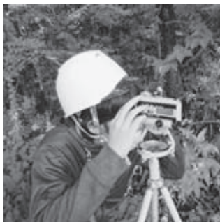
レーザー測量をする研修生
