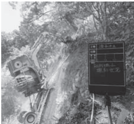
RCM地山掘削工（掘削状況）
