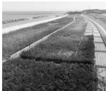
成長する海岸防災林 南相馬市鹿島区北老地区
