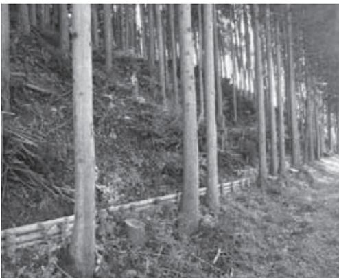
土砂の移動を抑える丸太筋工
