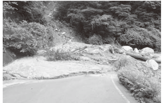
令和5年9月8日～9日の台風13号によるいわき市の被害状況
