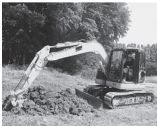
「車両系建設機械」ドラグショベルの掘削練習
