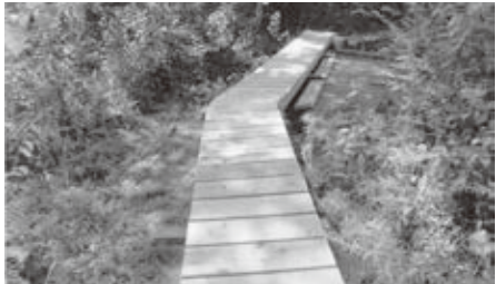
令和4年設置当時の状況
