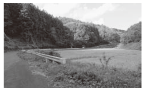
林業専用道「中沢線」予定地遠景
