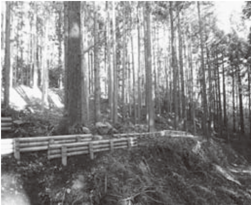
土砂の移動を抑える丸太筋工
