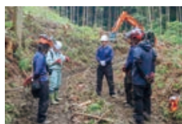
実地での確認検査①
