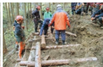
森林作業道作設(丸太組み)実習
