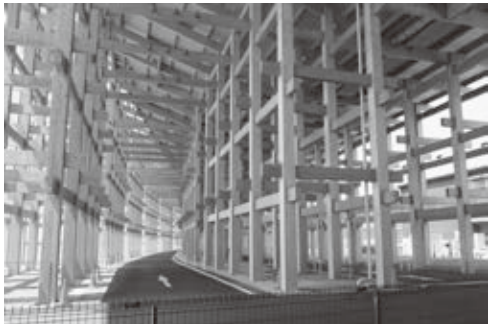
大屋根リング内部
