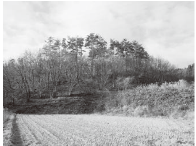
大波奈良婦集落 施工後（撮影：令和6年12月9日）
