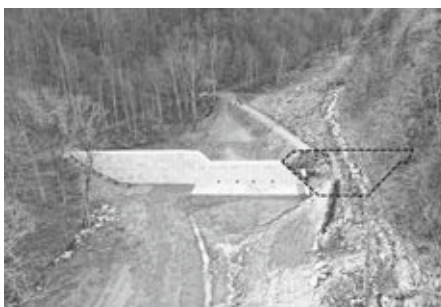
令和7年度完成予定の治山ダム（点線は施工予定）
