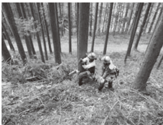
チルホールによる牽引
