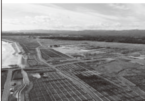
震災後再整備した海岸防災林
